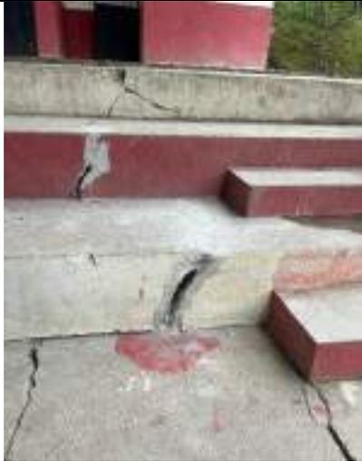
**Grietas en gradas:** Si se observan fisuras en las gradas, esto puede indicar que el problema se ha extendido a la cimentación o que la estructura no está distribuyendo adecuadamente las cargas. En las zonas de circulación, como las escaleras, el riesgo aumenta, pues cualquier falla o desprendimiento podría representar un peligro directo para los usuarios.
